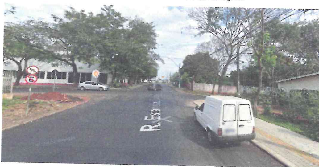
Vista terrestre do local antes da instalação, obtida através do Google Street View (imagem de agosto/2022)
