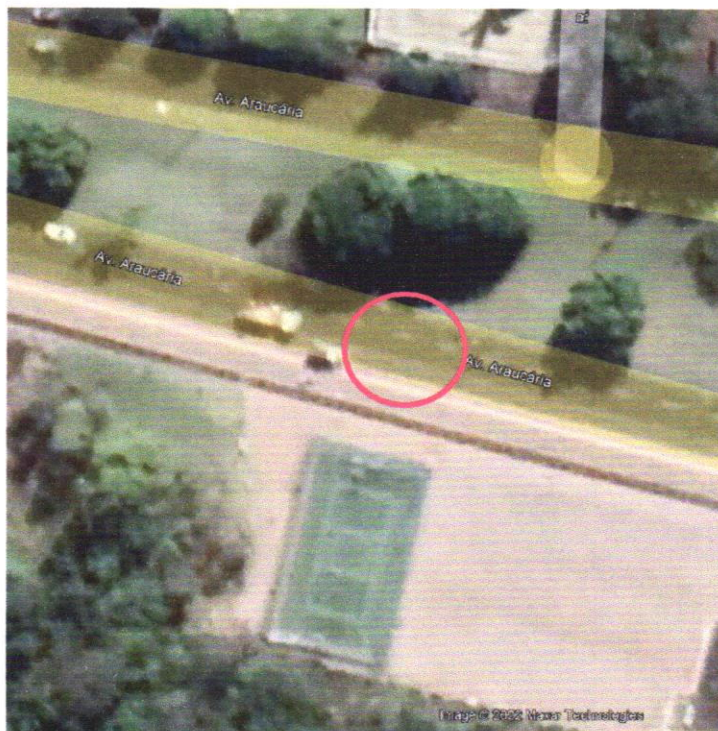
Vista aérea do local antes da instalação, obtida através do Goggle Earth (imagem de agosto/2021)
